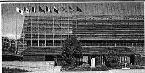
※2008年7月北海道洞爺湖サミット国際メディアセンター前で撮影。積水ハウス関東工場のゼロエミッションセンターに移設されました。同時に経済産業省指定の「茨城県 次世代エネルギーパーク」として一般公開されています。
